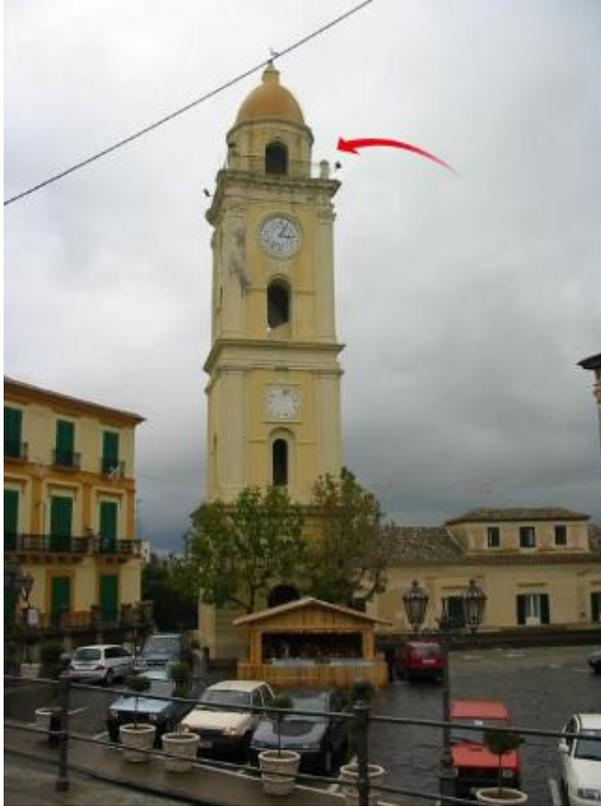
Rossano (CS), Torre dell'Orologio, antenne inserite nei quattro pilastri a sostegno della ringhiera
